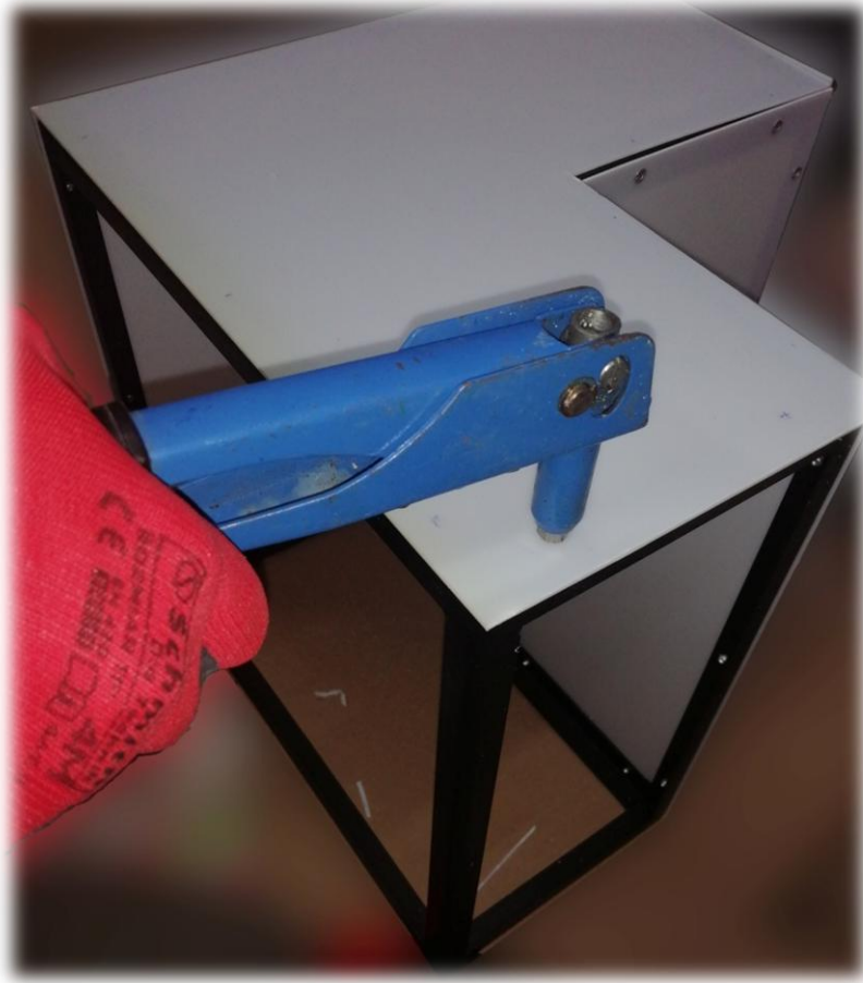
Rys. 7 Składanie obudowy(przytwierdzanie nieoklejonych paneli do ramy)
